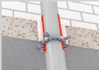
Montaj pe partea de jos a tavanului folosind dibluri metalice.
