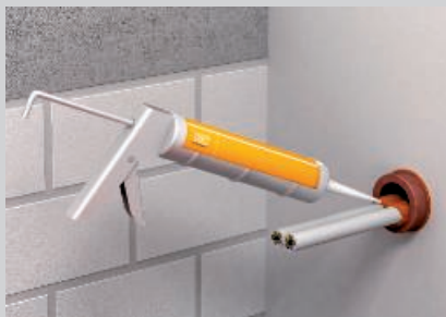
Montarea mini casetelor pentru conducte FBA-DR în pereți despărțitori ușori.
