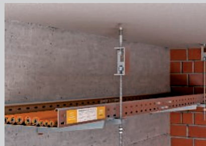
Fixarea pe tavan a tijelor filetate cu clemă pentru protecție la foc.
