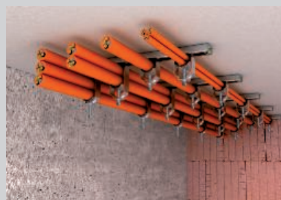
Montaj orizontal al cablurilor sub tavan folosind bride.
