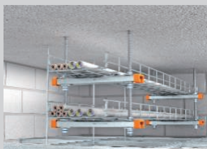
Montaj pe tavan în două straturi în partea de sus a tavanului de protecție la foc suspendat.
