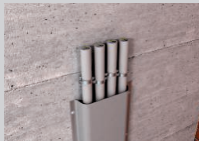
Fixarea bandajului cu șine metalice în cazul instalării cu o bridă simplă.
