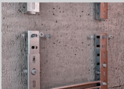
Realizarea punctelor de îmbinare cu conectori înșurubați.
