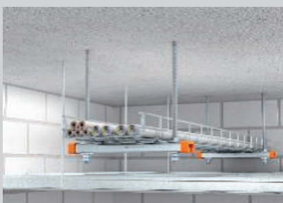
Montaj pe tavan într-un singur strat în partea de sus a tavanului de protecție la foc suspendat.
