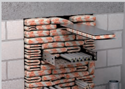
Tablă ca asistență de montaj pentru ultima poziție a pernuțelor.
