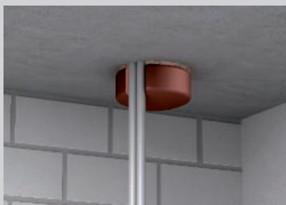
Tăierea și montarea dopurilor în plafoane.
