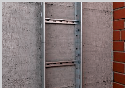
Montaj direct al podului de cabluri vertical pe un perete masiv.
