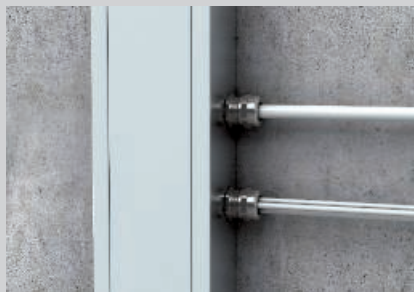
Leșire cablu cu înșurubări V-TEC, cu inel de etanșare individual sau multiplu.
