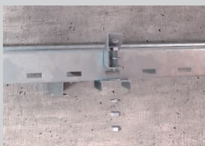
Montaj pe diagonală a componentelor de prindere folosind șuruburi și piulite hexagonale.
