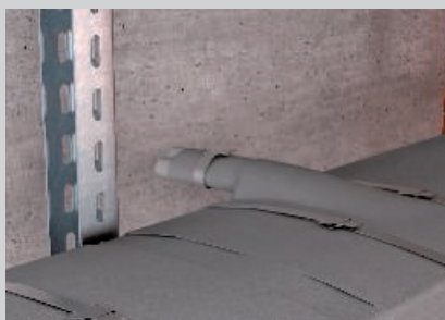
leșire pentru cabluri, cu bandaj.
