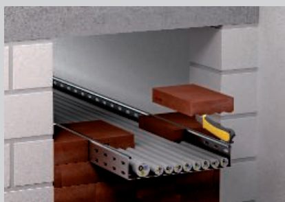
Montarea blocurilor tăiate.
