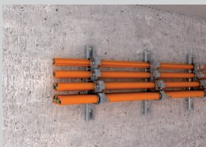
Montaj orizontal al cablurilor pe perete folosind bride.
