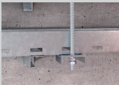
Fixarea tijei filetate verticale pe piesa racord.
