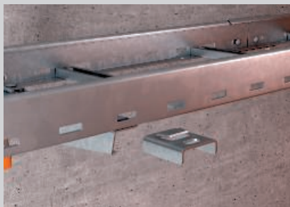
Fixarea piesei racord pe centura inferioară a traversei pentru scară.
