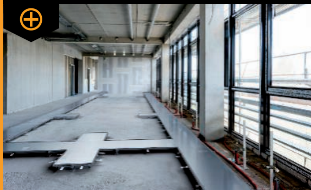
Sistem acoperit cu șapă
