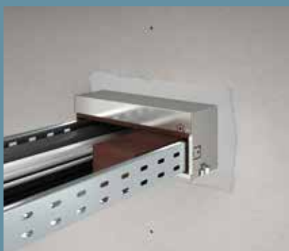
Introducerea blocului de inserție tăiat la dimensiune în spațiile goale mai mari
