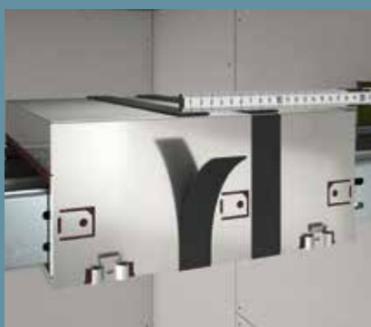
Măsurarea grosimii peretelui și aplicarea benzilor de grafit la distanța corespunzătoare
